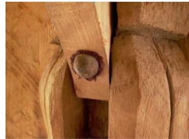
Drei der strassenseitigen Dachbalken wurden aufgrund starker Durchbiegung, unzureichender Länge und starker Rissbildung gegen neue Pappelholzbalken ersetzt. Die alten Balken konnten auf der Hofseite über den Türflügeln wiederverwendet werden, da dort geringere Anforderungen an die Statik, die Länge und die Form der Balken gestellt wurden.
